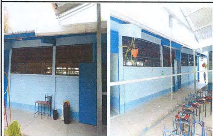
Foto 3: Balcones para los ventanales frontal aula 1, 2 y 3. Instalados
