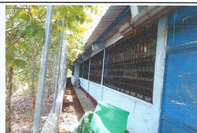
Foto 4: Balcones lado lateral aulas 1, 2 y 3. Instalados
