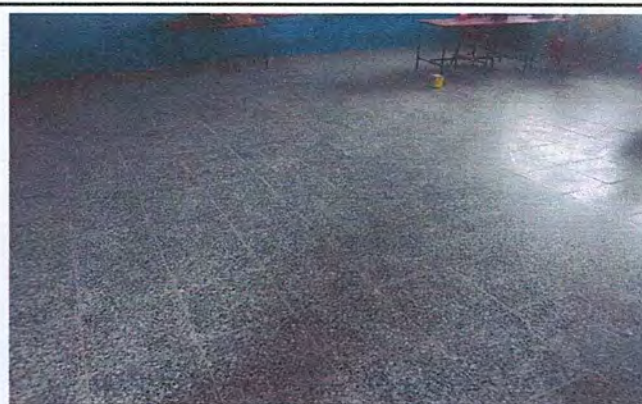
Foto 2: Pisos instalados Aula 3
