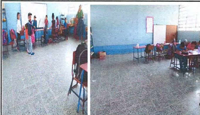
Foto 1: Piso cerámico mejorado e instalado. Aula 1 y 2.
